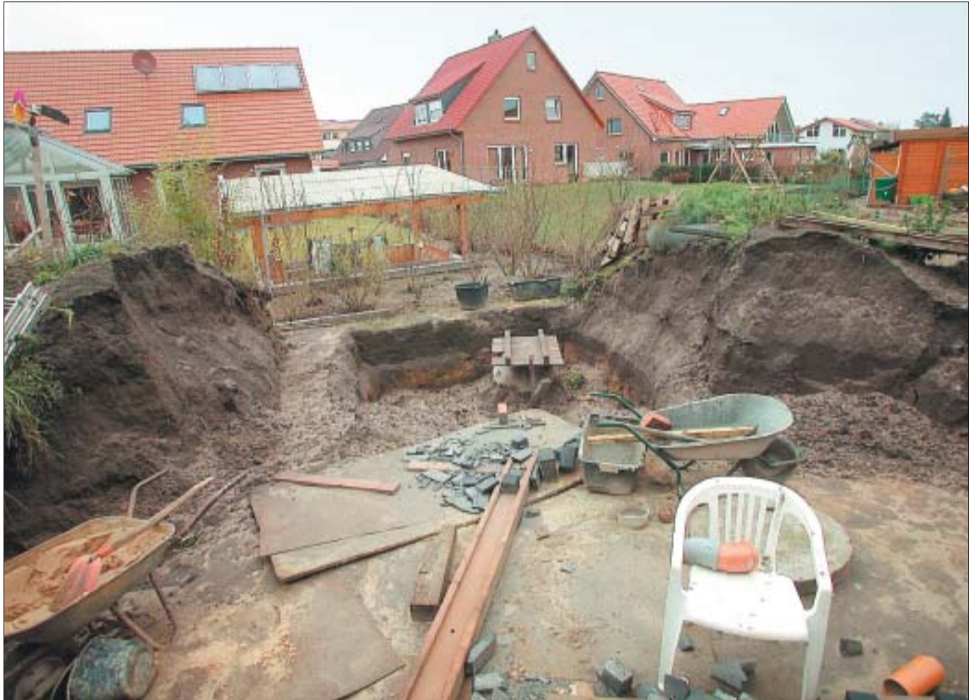
In dieser Baugrube hinter dem Haus der Familie Braun an der Allerstraße ist die Urne bei Grabungsarbeiten entdeckt worden.
